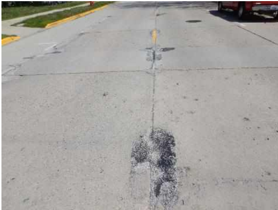
OAKS-S13-Overview-(Sample Unit No. 01)
