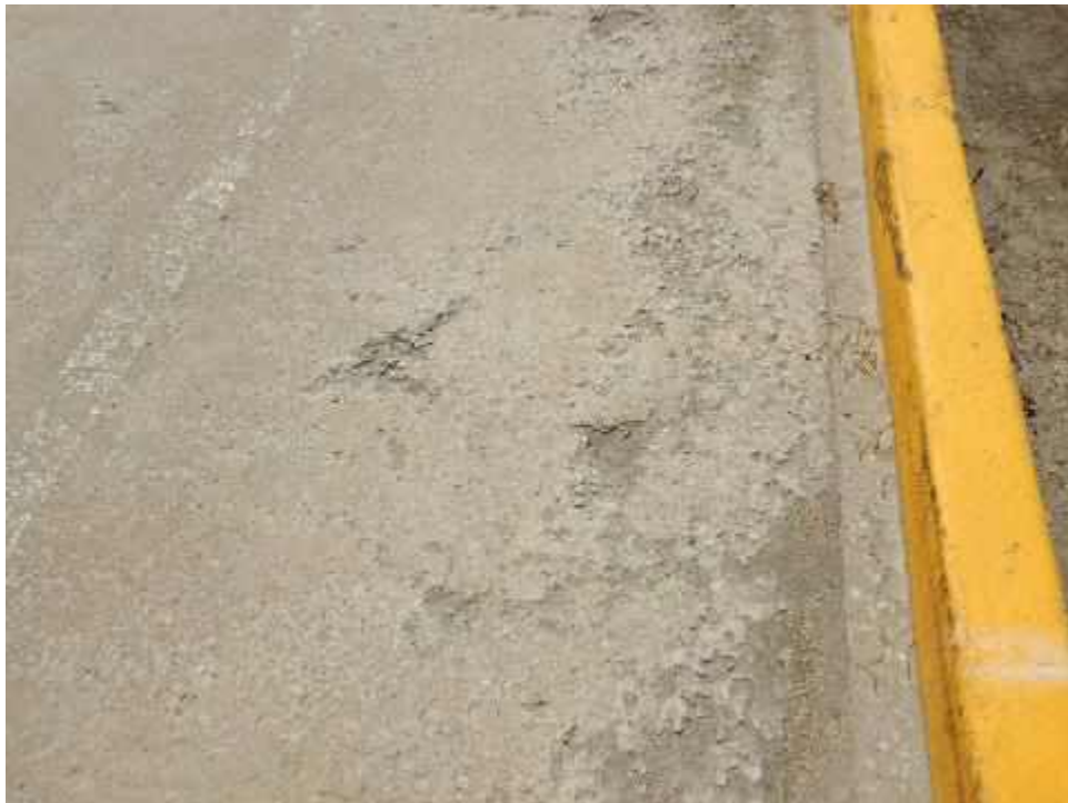
GREGYD-UW12D-Scaling-(Sample Unit No. 02)
