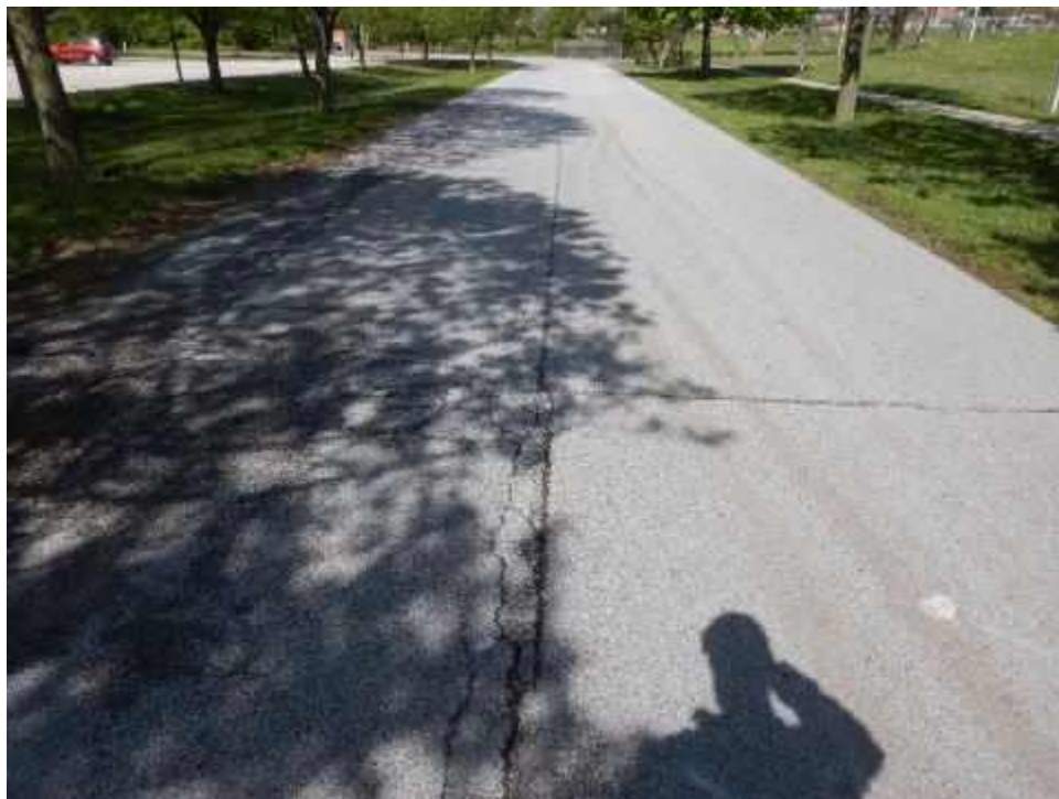
HAZELWDD-E00A-Overview-(Sample Unit No. 01)
