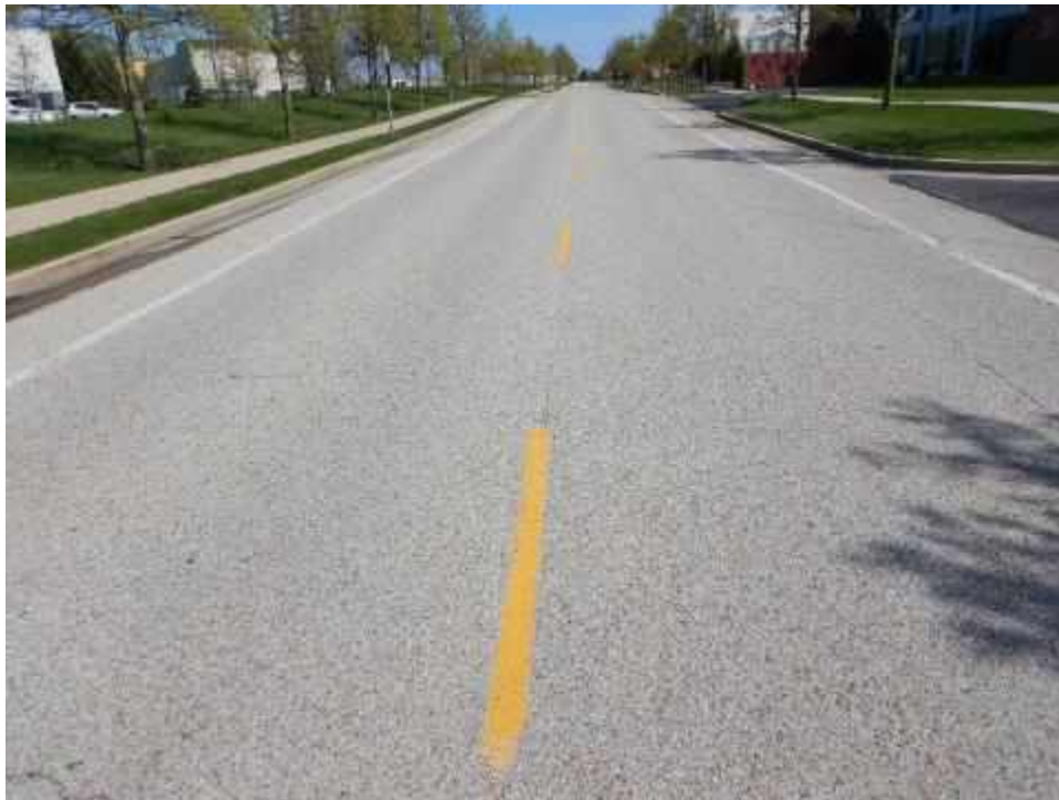
OAKS-S20A-Overview-(Sample Unit No. 01)
