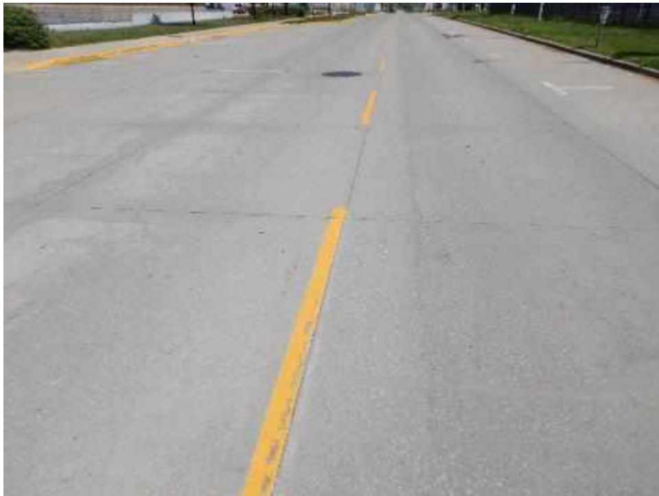
OAKS-S12-Overview-(Sample Unit No. 01)
