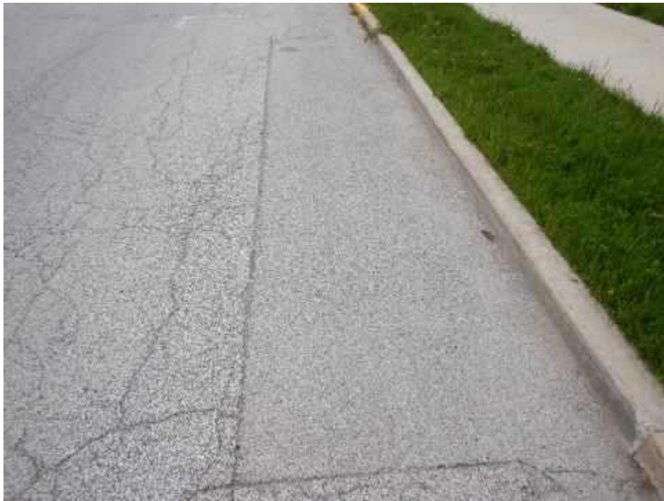
PENSYA-UW12B-Patching-(Sample Unit No. 02)
