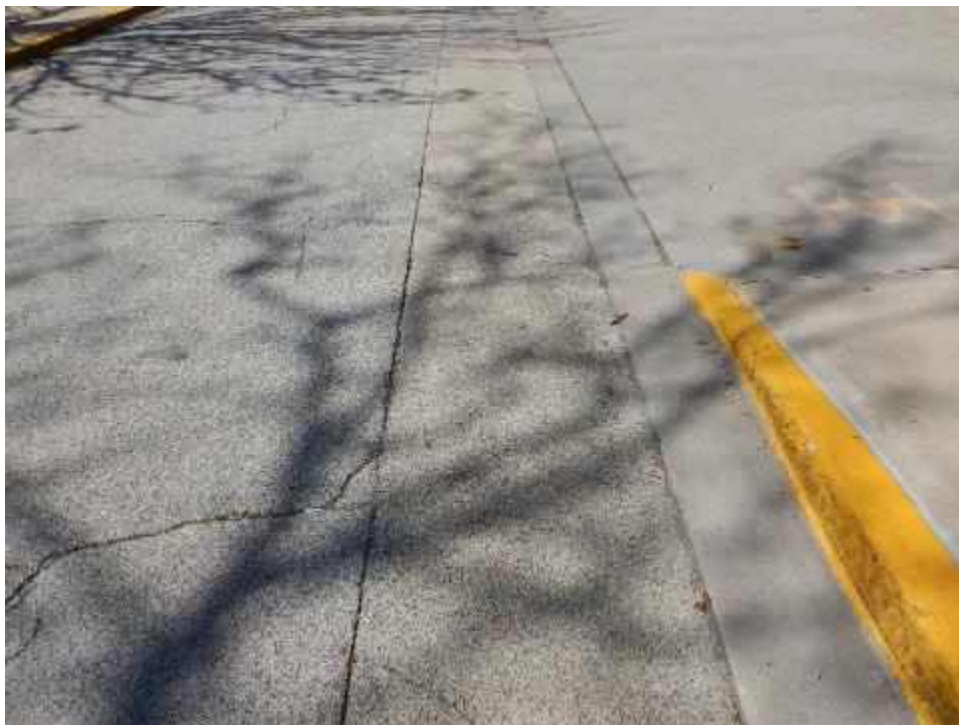
EUCLDS-S12-Patching-(Sample Unit No. 01)
