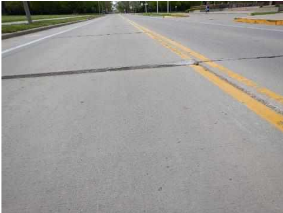
GREGYD-UW12C-Faulting-(Sample Unit No. 01)
