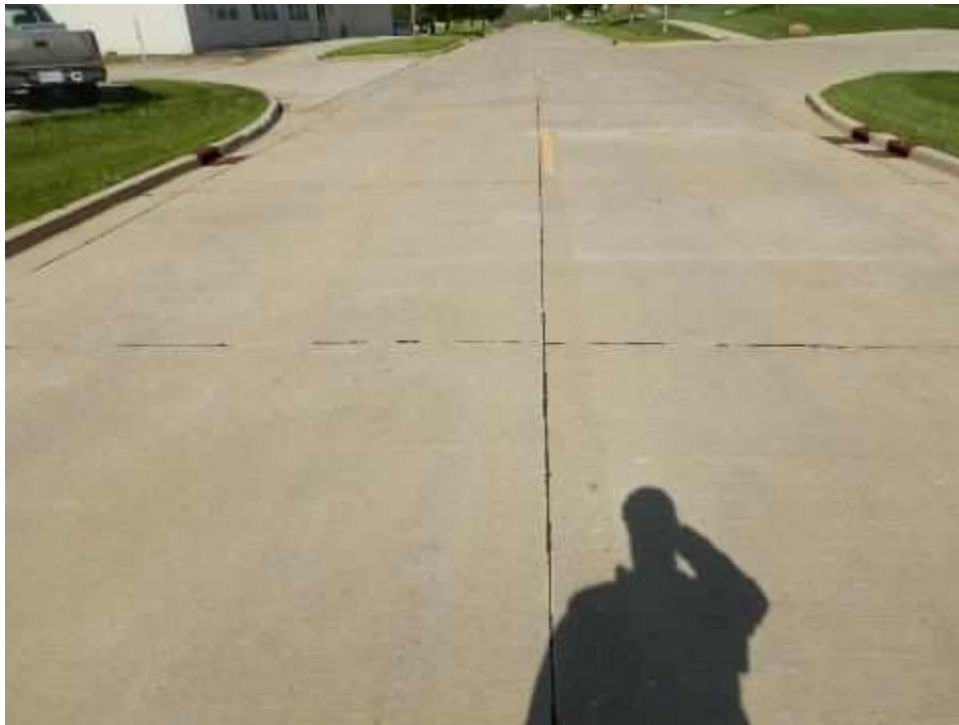
HAZELWDD-E01A-Overview-(Sample Unit No. 01)
