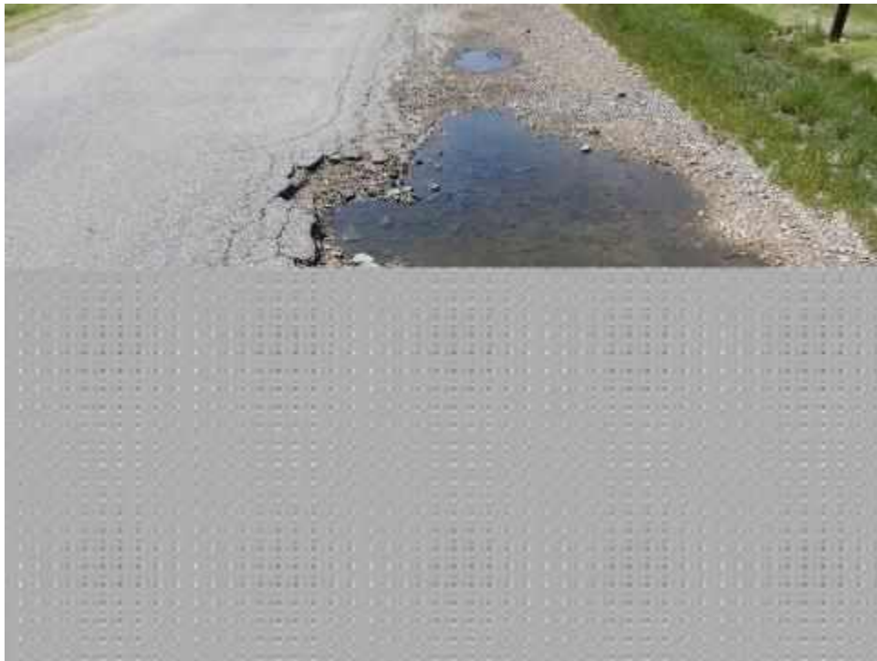
GOODWINA-US17-Raveling-(Sample Unit No. 01)
