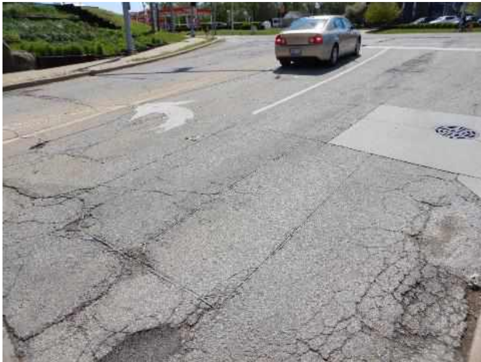
STADMD-E00A-Overview-(Sample Unit No. 01)
