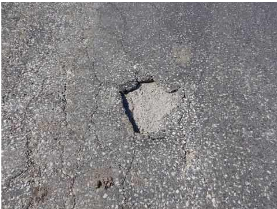
GOODWINA-US19-Pothole-(Sample Unit No. 01)
