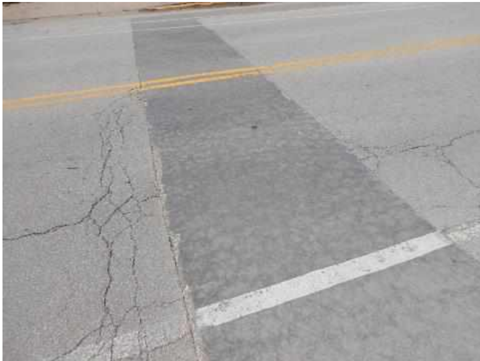
FOURTS-S11-Patching-(Sample Unit No. 02)
