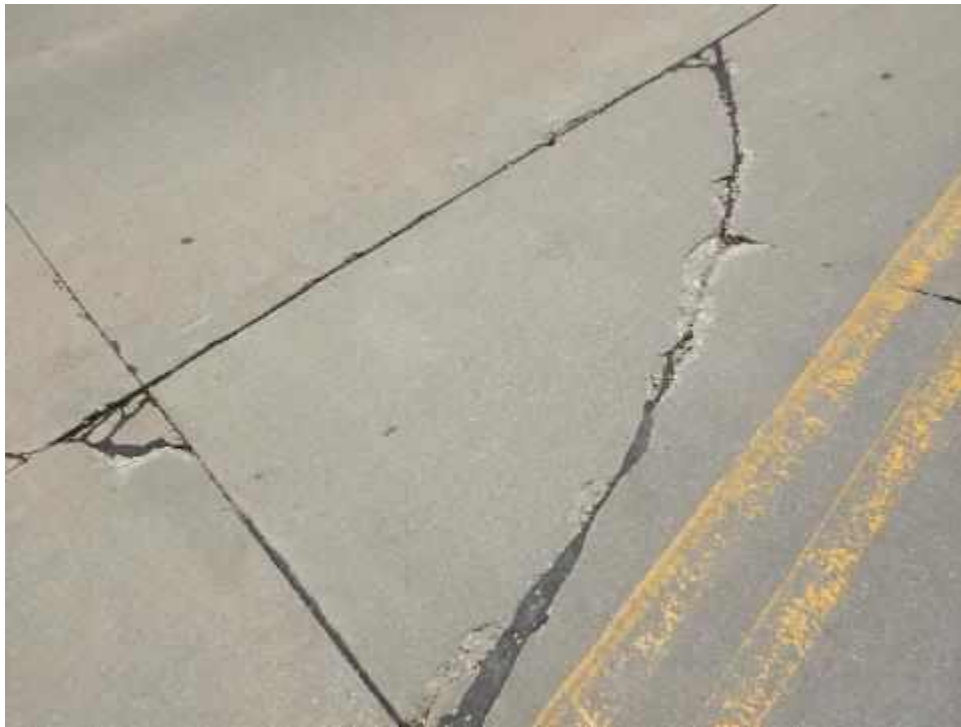
GREGYD-E04-Corner Break-(Sample Unit No. 01)
