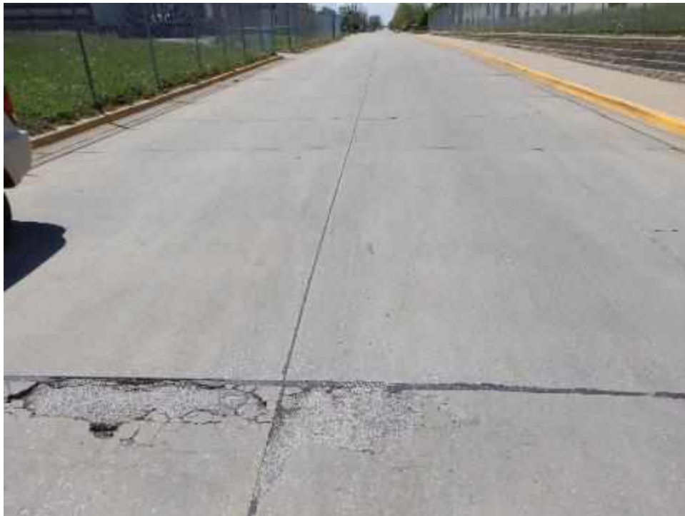
OAKS-S10A-Overview-(Sample Unit No. 01)
