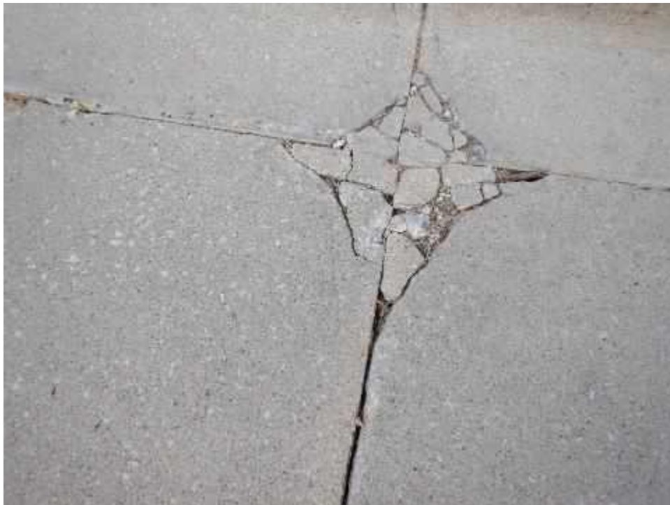
GREGYD-UW12D-Corner Break-(Sample Unit No. 01)
